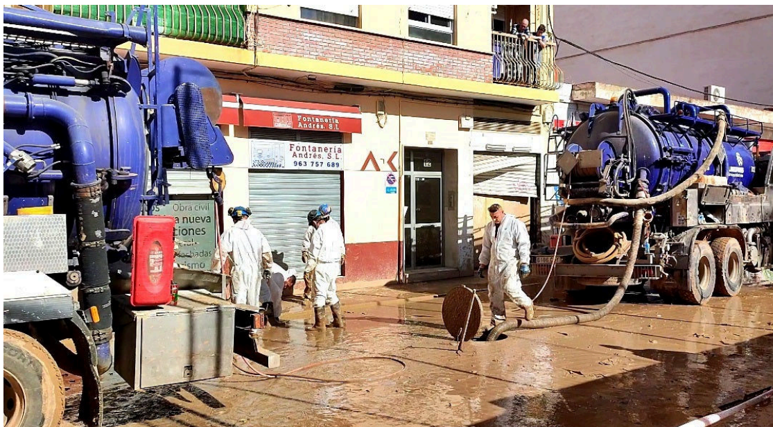
Un camión cuba limpia el alcantarillado en el municipio de Benetússer
