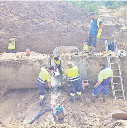
Los trabajos de reparación de la tubería.
